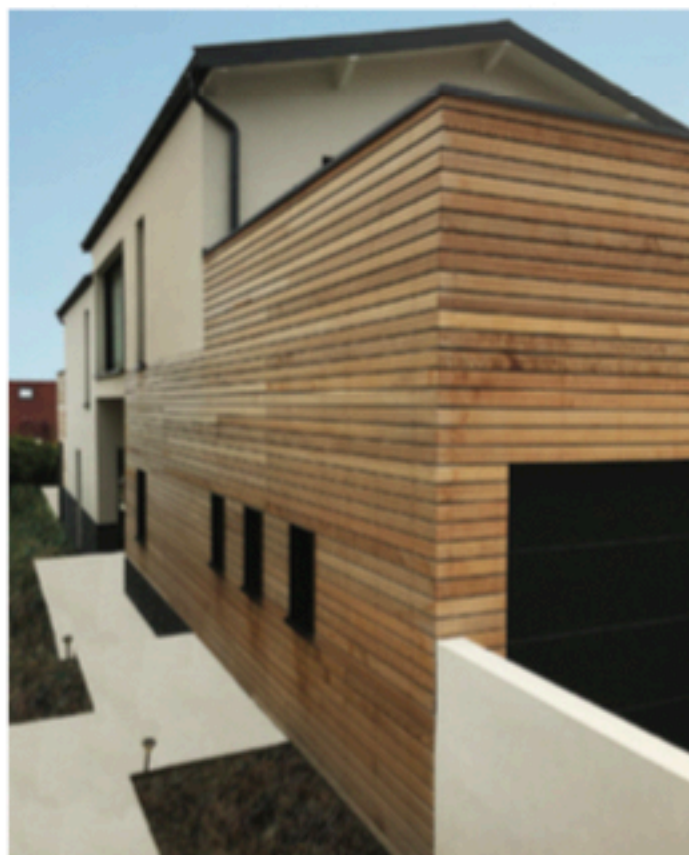
Construction en bois à Rueil-Malmaison
