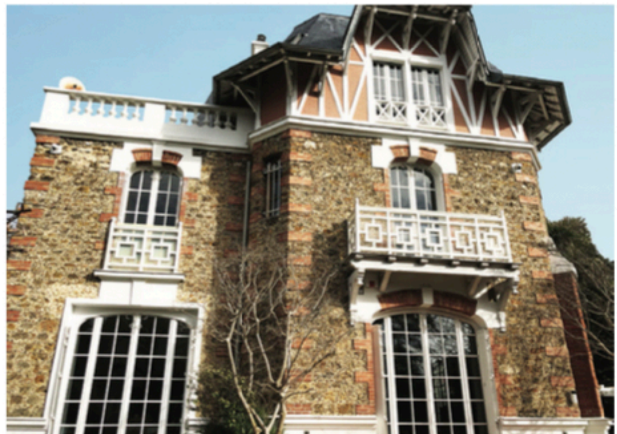
Rénovation à Saint-Cloud
